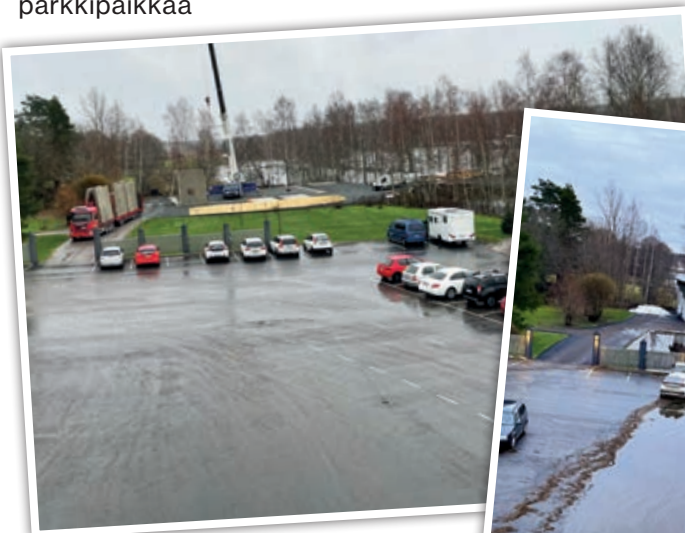
Lapin uusi varasto rakenteilla marraskuussa 2023.
